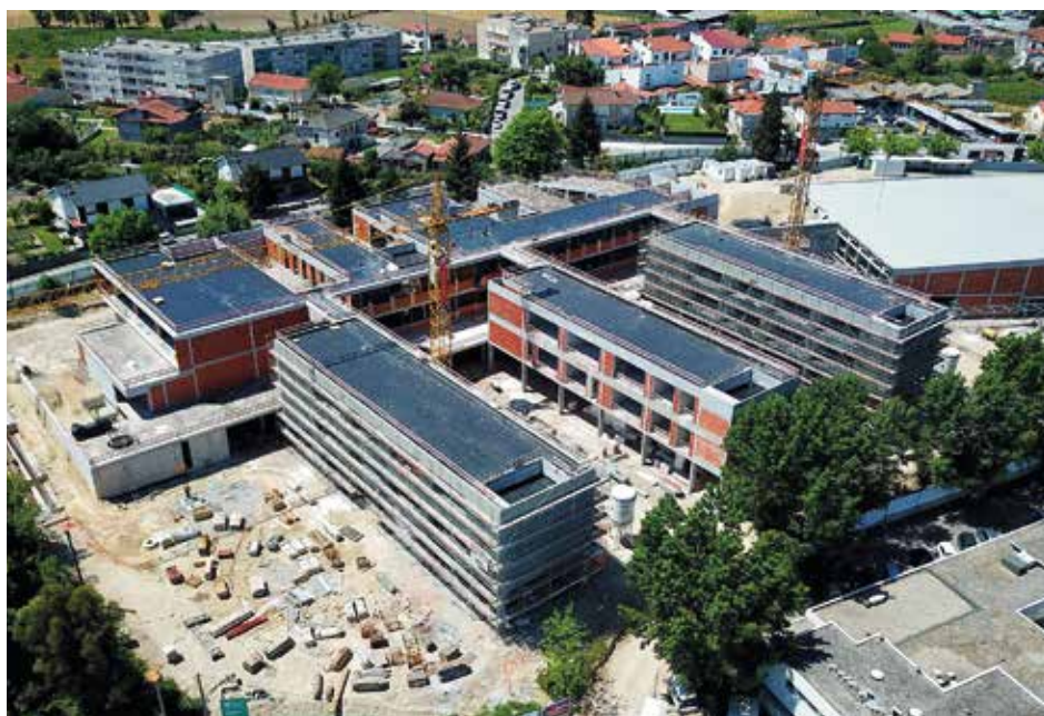
Centro Escolar das Taipas – Portugal
