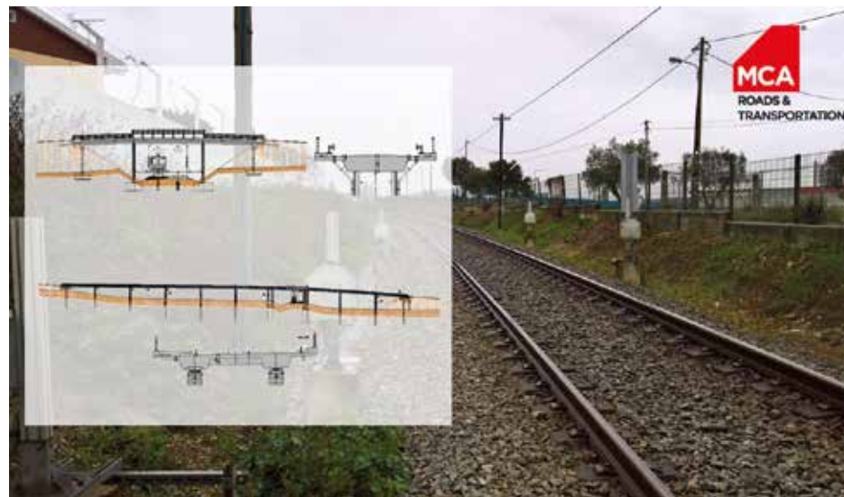
Projeto de modernização de troço de 43 km da linha ferroviária do Oeste - Portugal
